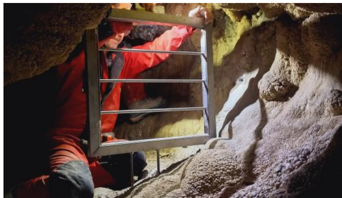
Mise en place de la grille
