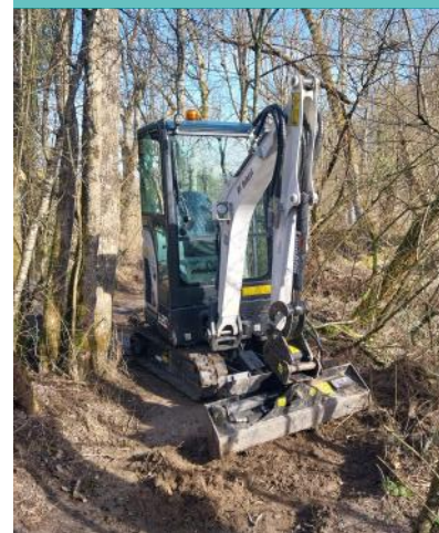
Intervention de la minipelle mécanique (entreprise Yan Bertholon)
