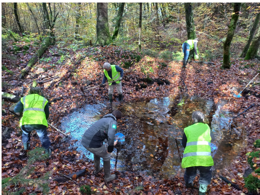
Chantier de curage des mares.
