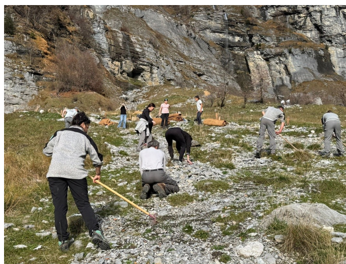
Chantier collectif à Sixt-Fer-à-Cheval /Passy en réunion de service Réserves naturelles, septembre 2025 © Asters-CEN74
