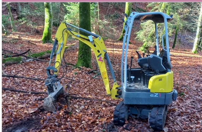
Mini pelle utilisée pour la réalisation de ces travaux
