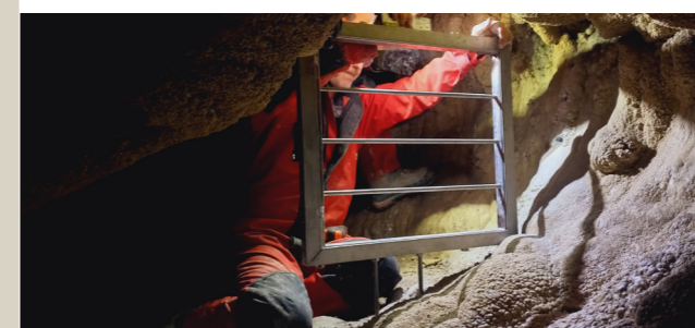
Pose de la grille de protection dans la grotte de Salenton © J.Heuret
