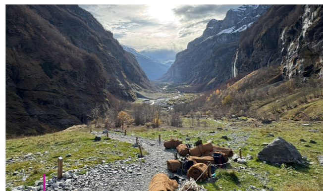
Restauration du sentier du Bout du Monde dans la Réserve Naturelle nationale de Sixt-Fer-à-Cheval/Passy ©N.Soupragen-Cavery
