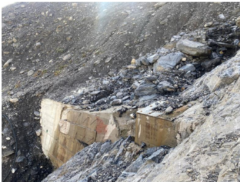
0502 : à droite, grille et chambre de prise d'eau complètement engravées
